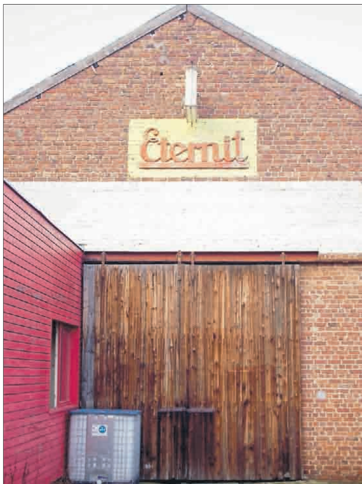
Ein ehemaliges Eternitlager, wie der Schriftzug vermuten lässt.
